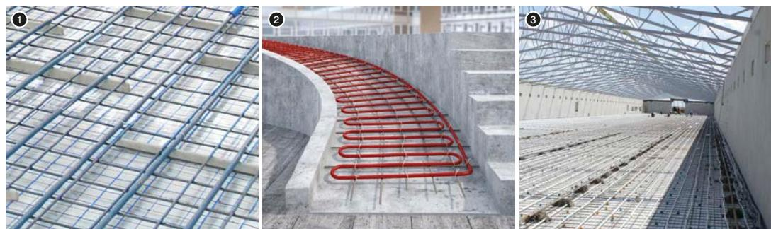
KAN-therm NET – это система крепления труб к основаниям разного вида (к теплоизоляции, к грунту, к бетонному основанию). Конструкция отопительного прибора панельно-лучистого отопления (или охлаждения) может отличаться в зависимости от используемой теплоизоляции (или ее отсутствия), а также от вида и толщины слоев над трубами.
